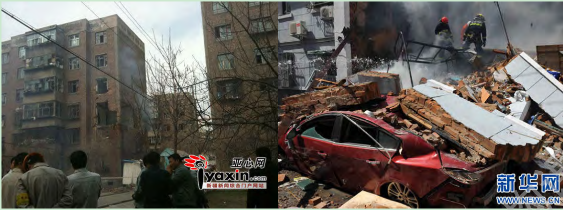
图 1.8 乌鲁木齐某一居民楼局部倒塌
