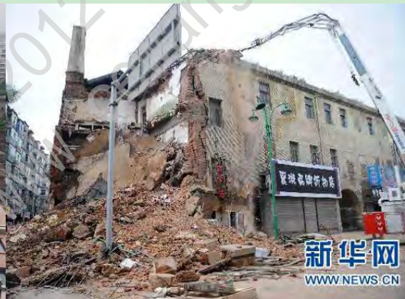
图 1.7 长春某一居民楼发生局部倒塌
