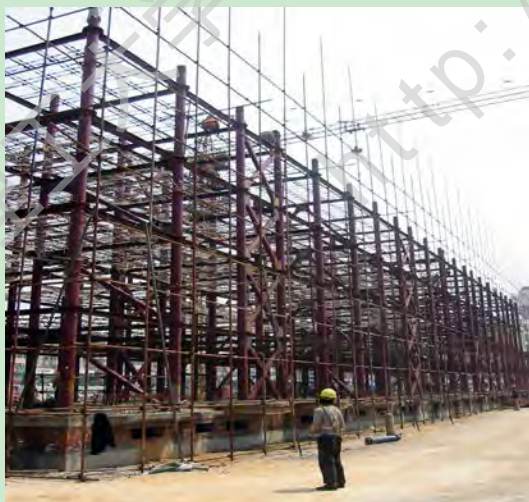
图 1.1 外加强环式节点框架
