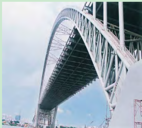
图 1.2 钢管混凝土在拱桥中的运用
