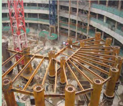
(b) 津塔钢管混凝土柱
