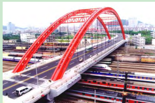
(b) 深圳北站大桥
