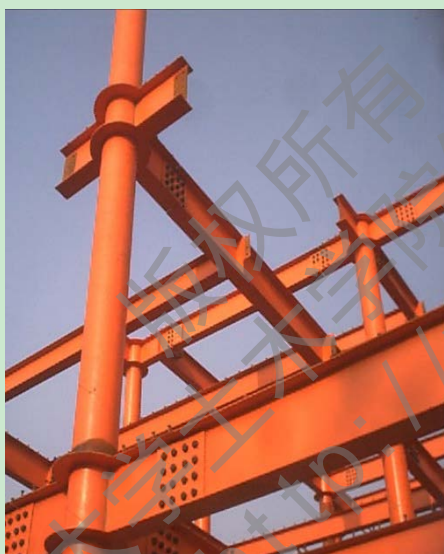
图1.1 施工中的圆钢管混凝土框架
