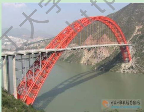
图 1.6 重庆巫峡长江大桥
