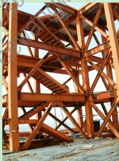
图1.2 施工中的矩形钢管混凝土框架
