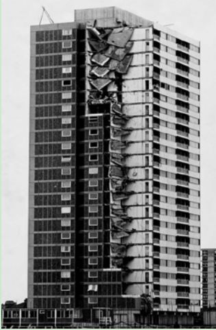
图 1.4 1968 年 Ronan Point 公寓倒塌事件
