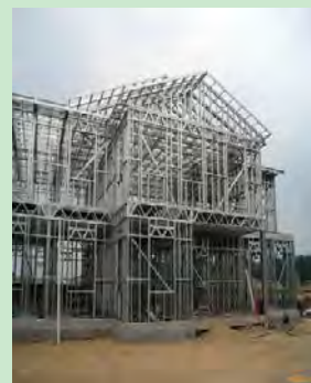
图 1.3 冷弯薄壁型钢住宅结构骨架
